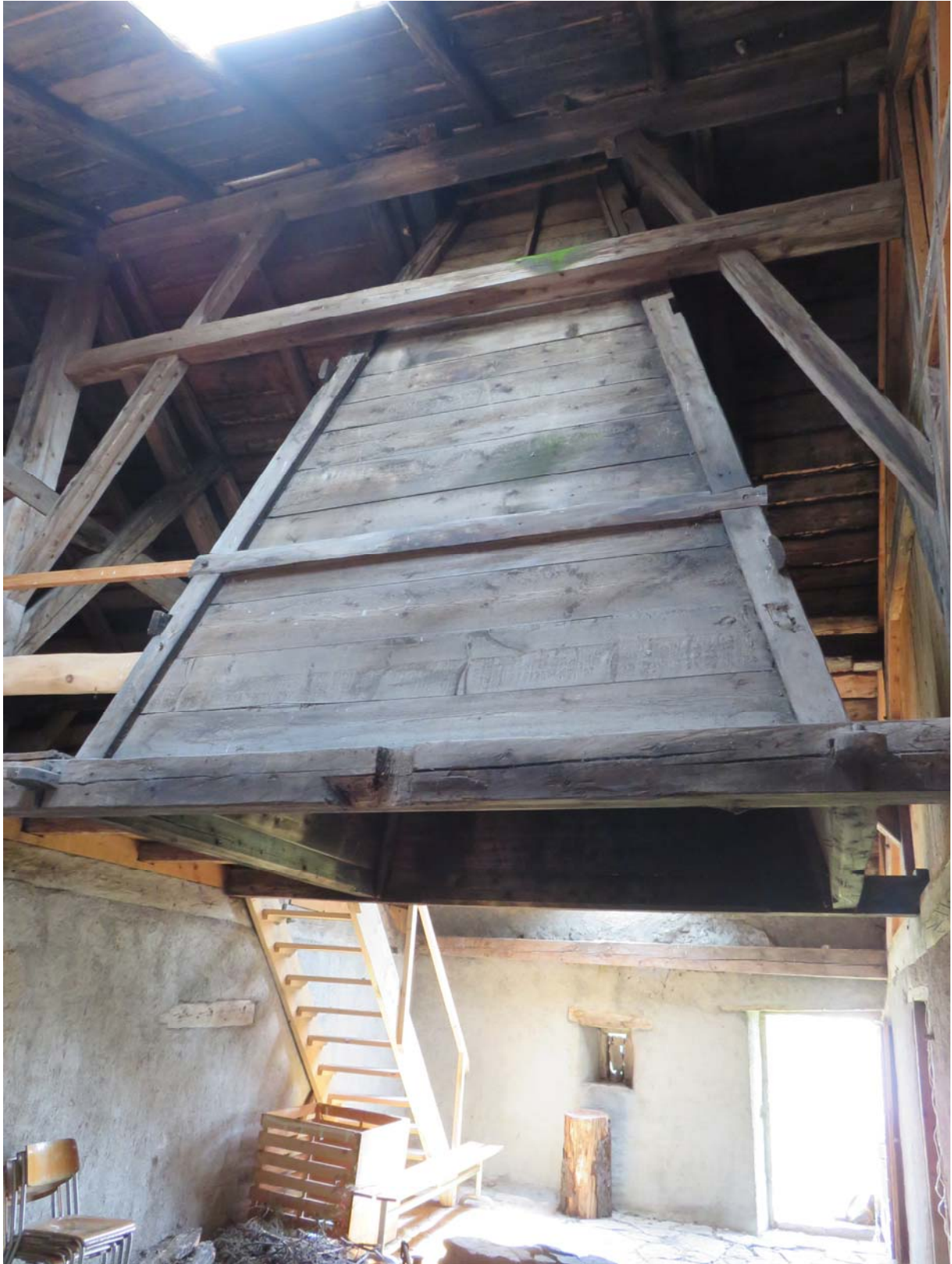
Cheminée visible jusqu'au toit, puisque la cuisine n'avait pas de plafond.
