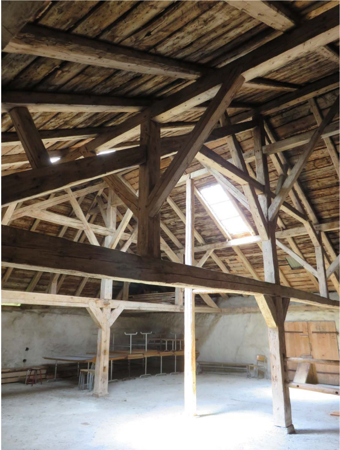
Une charpente magnifique. Dommage seulement que les sols de l'écurie aient été bétonnés. Les planches avaient un charme de beaucoup supérieur.
